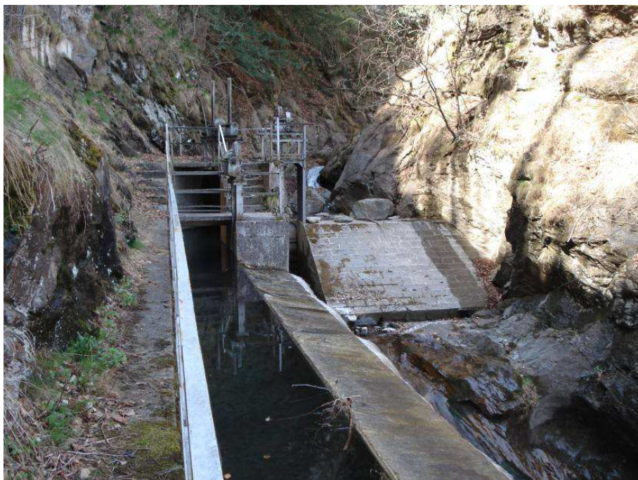
Figura 51 – traversa di sbarramento ed opera di presa su rio Galambra – vista verso monte
