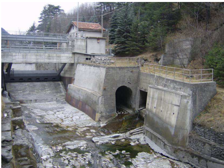
Figura 4 – traversa di sbarramento e galleria di by-pass in loc. Serre la Voute – vista verso monte
