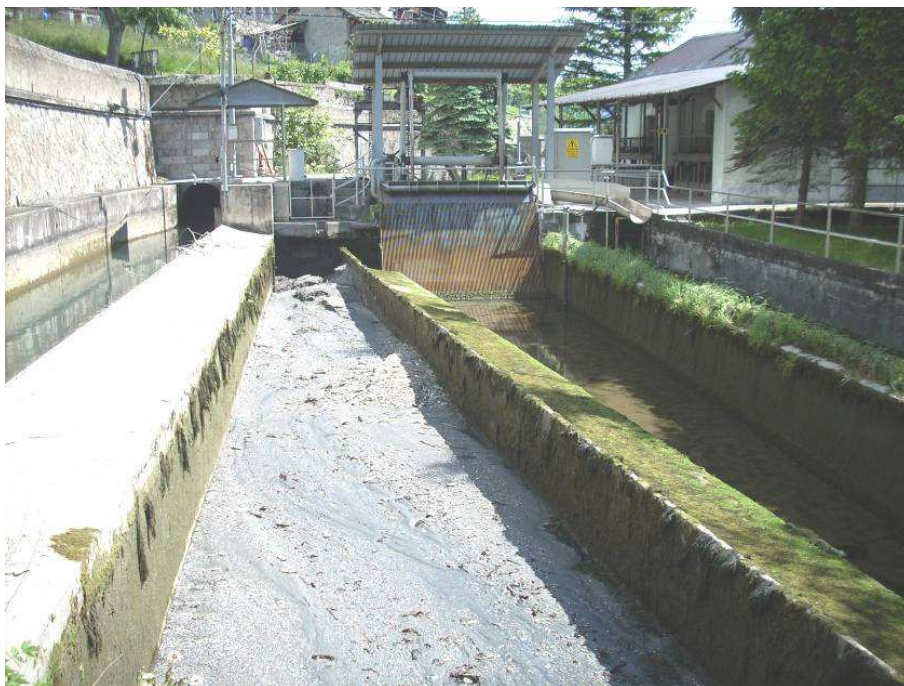
Figura 75 – manufatto di ripartizione delle portate in area Ramat in arrivo dalla galleria di derivazione – vista verso valle
