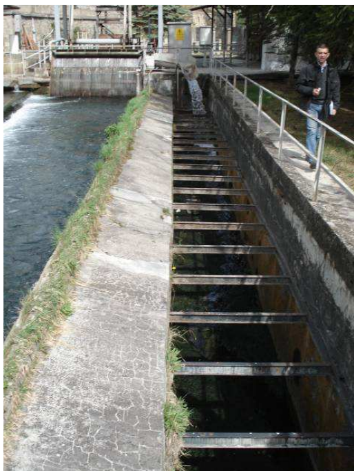
Figura 77 – manufatto sfioratore di troppo pieno delle portate in area Ramat in arrivo dalla galleria di derivazione – vista verso monte
