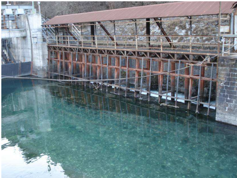
Figura 6 – opera di presa in loc. Serre la Voute – manufatto paratronchi
