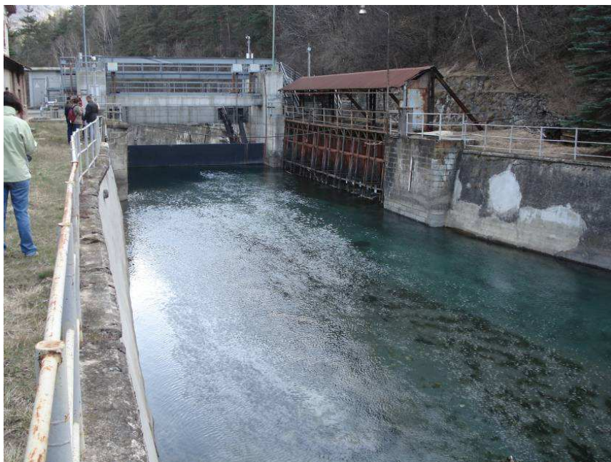
Figura 1 – traversa di sbarramento ed opera di presa laterale in loc. Serre la Voute – vista verso valle
