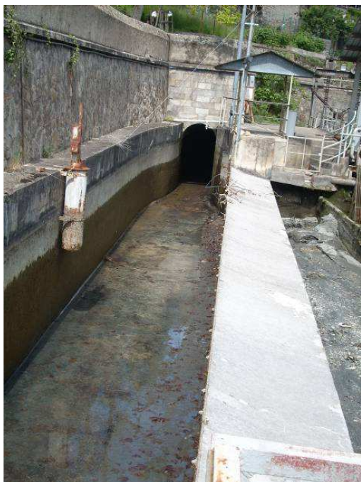
Figura 74 – manufatto di ripartizione delle portate in area Ramat in arrivo dalla galleria di derivazione – vista verso monte (sx) e verso valle (dx)
