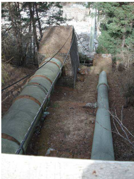
Figura 33 – manufatto sifone in attraversamento alveo Dora Riparia – vista da versante destro a sinistro
