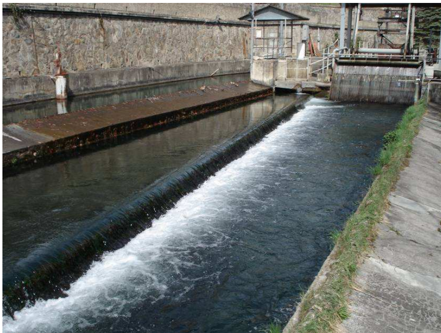
Figura 76 – manufatto di ripartizione delle portate in area Ramat in arrivo dalla galleria di derivazione – vista verso valle
