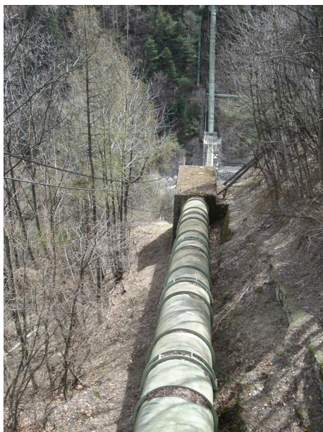
Figura 34 – manufatto sifone in attraversamento alveo Dora Riparia – vista da versante sinistro a destro
