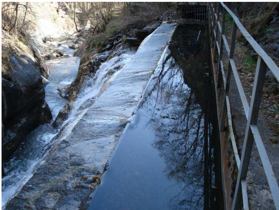
Figura 50 – manufatto sfioratore troppo pieno a valle traversa di sbarramento su rio Galambra – vista verso valle
