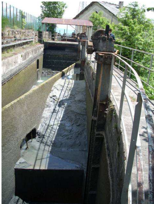
Figura 78 – manufatto di ripartizione delle portate in area Ramat a monte del bacino di accumulo – vista verso valle
