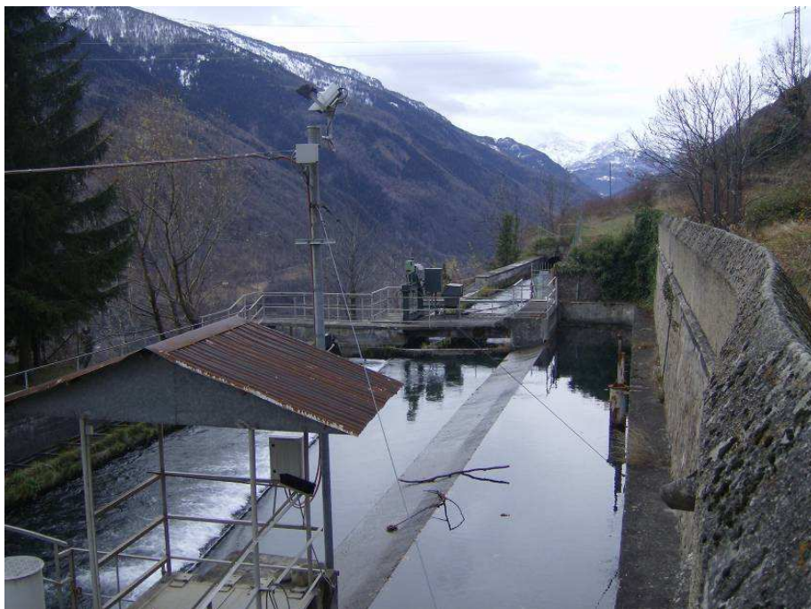
Figura 72 – manufatto di ripartizione delle portate in area Ramat in arrivo dalla galleria di derivazione – vista verso monte
