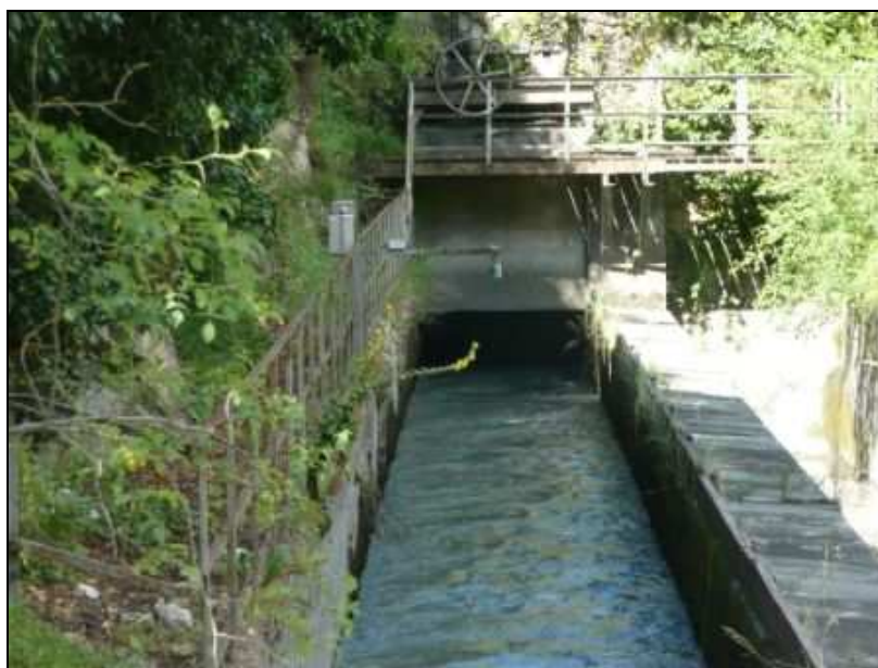
Figura 143 – Ingresso in galleria del canale derivatore
