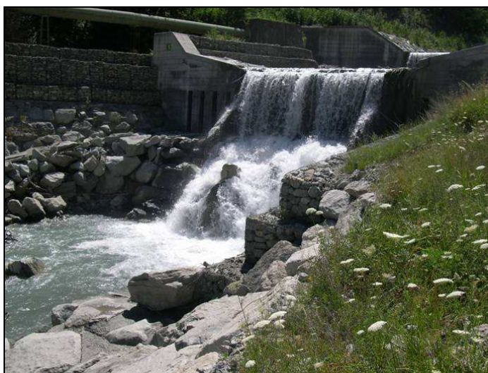
Figura 140 - Sequenza di briglie senza scale di risalita dei pesci poche centinaia di metri a valle della traversa di Serre la Voute
