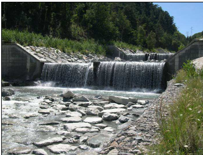
Figura 140 - Sequenza di briglie senza scale di risalita dei pesci poche centinaia di metri a valle della traversa di Serre la Voute
