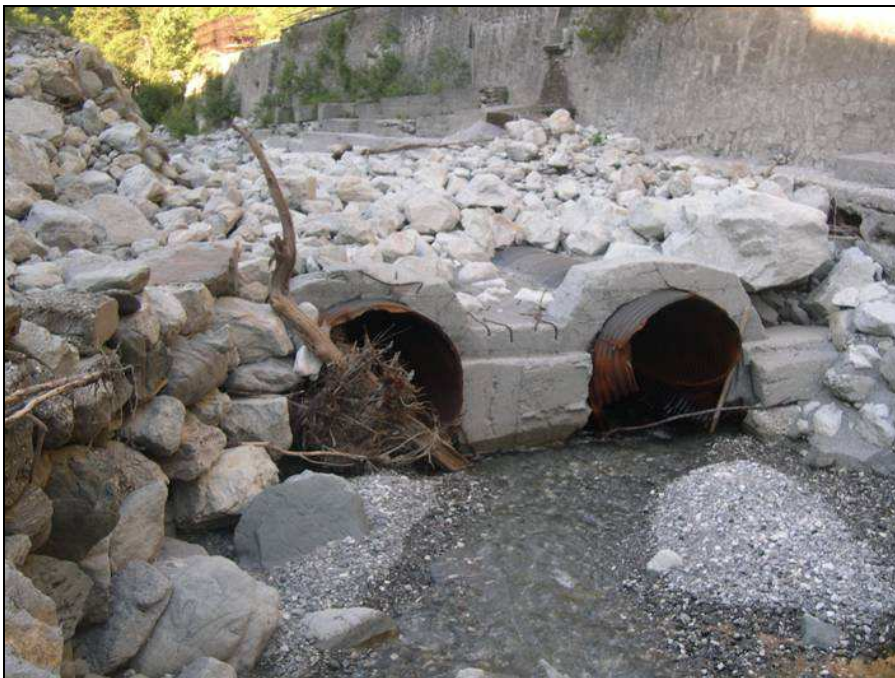
Figura 140 - Sequenza di briglie senza scale di risalita dei pesci poche centinaia di metri a valle della traversa di Serre la Voute
