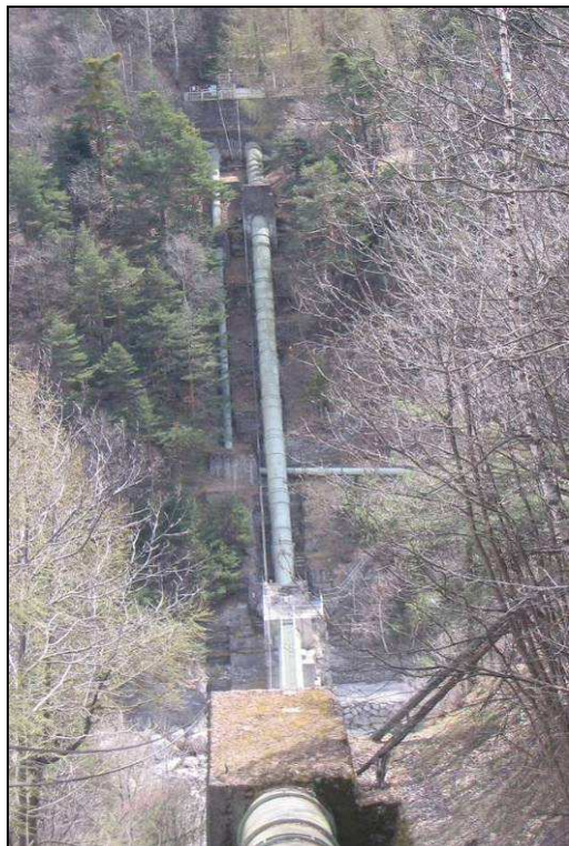
Figura 9 – Sifone del canale di derivazione Salbertrand-Chiomonte
