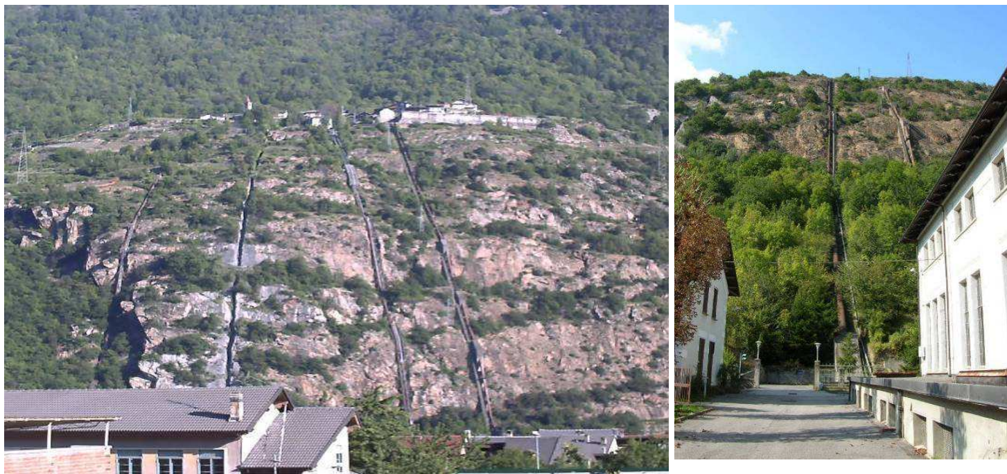
Figura 4 - Condotte forzate alla centrale di Chiomonte
