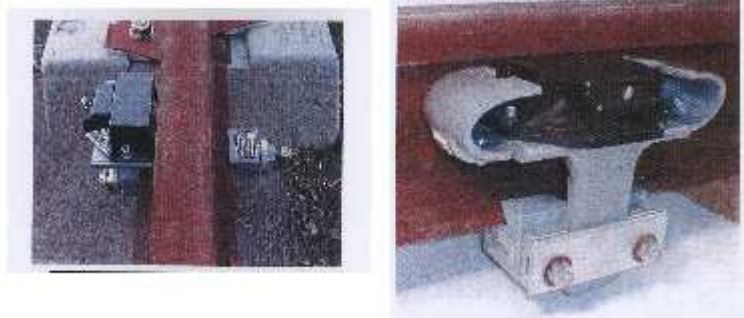
Figure 20 - Photo de montage des détecteurs d'essieux sur griffe avec protection du capteur
