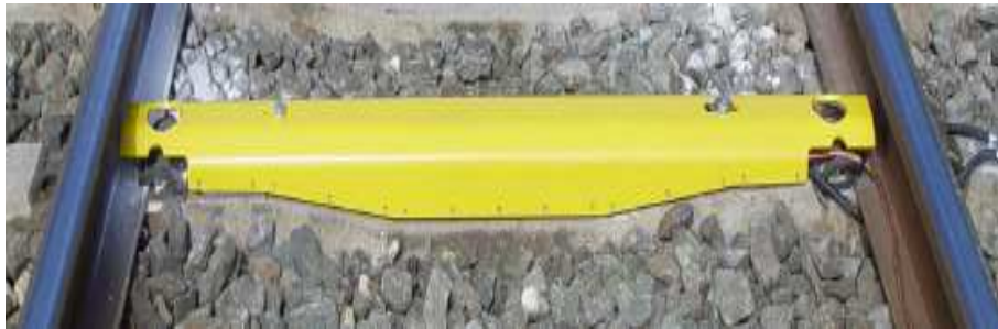
Figure 8 – Ensemble de capteur de détection équipés de leur protection
