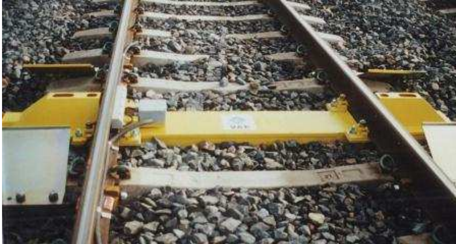
Figura 20 - Sostituzione di una traversina con una traversina speciale che integra i DBC
