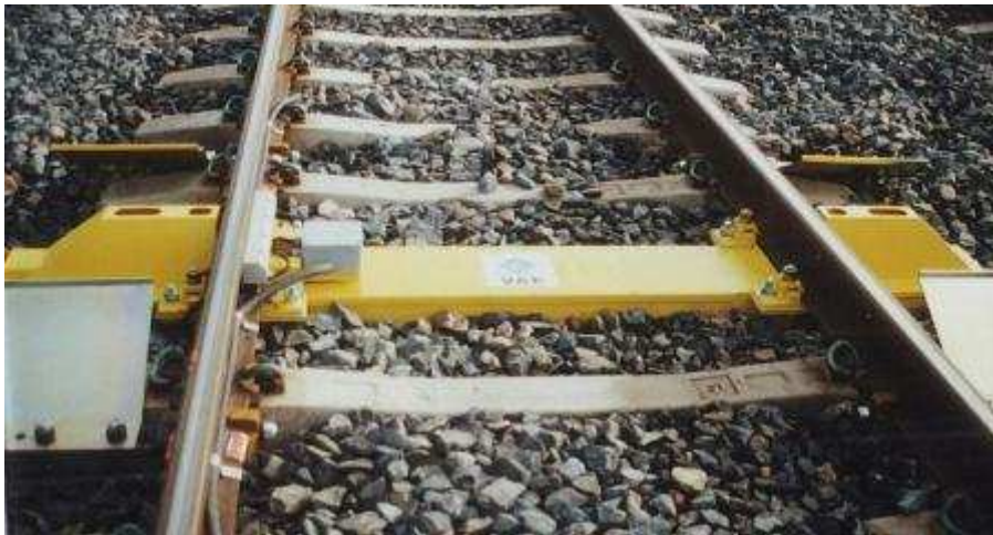
Figure 4 - Remplacement d'une traverse par une traverse spéciale Intégrant les DBC
