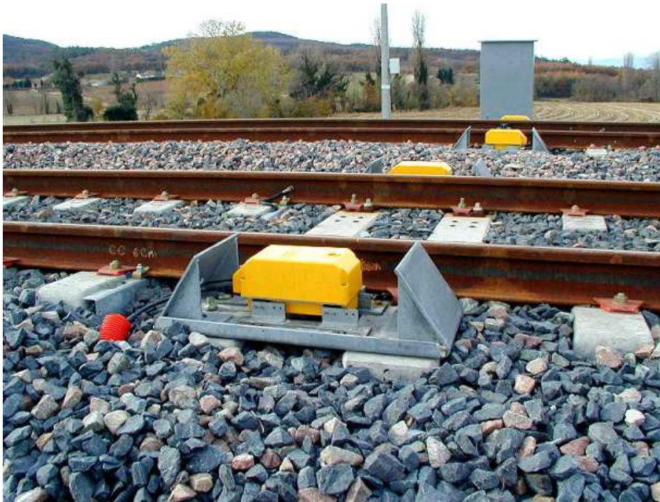
Figure 5 - Mise en oeuvre par fixation sur traverses spéciales
