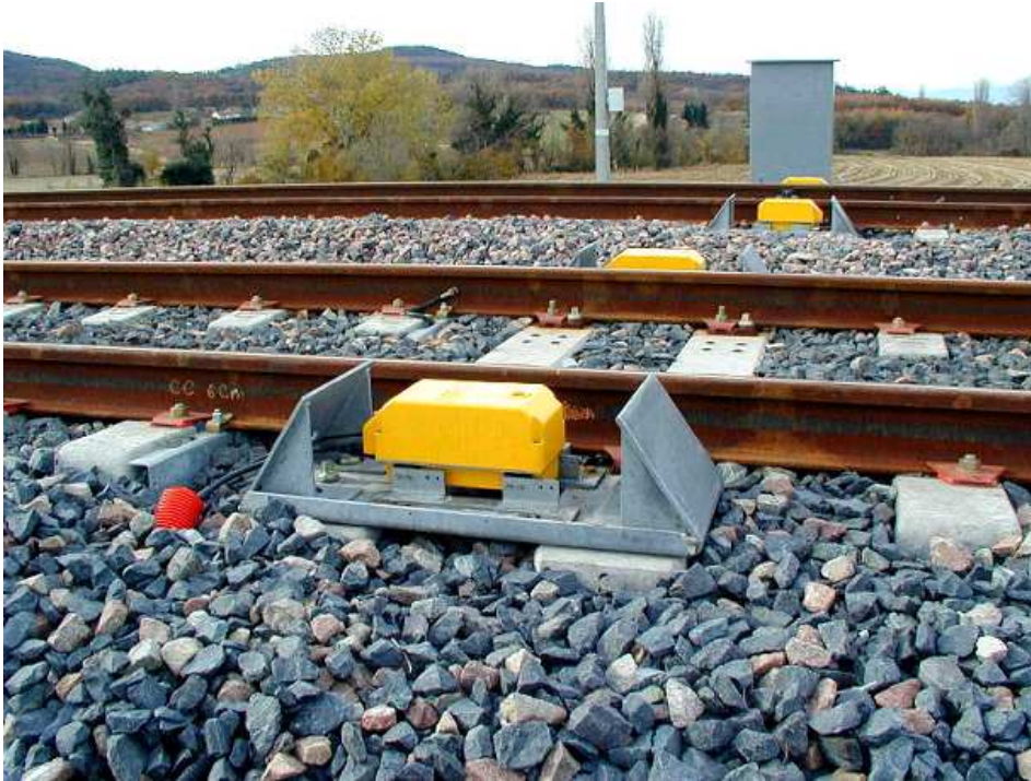
Figura 1 - Installazione mediante fissaggio su traversine speciali
