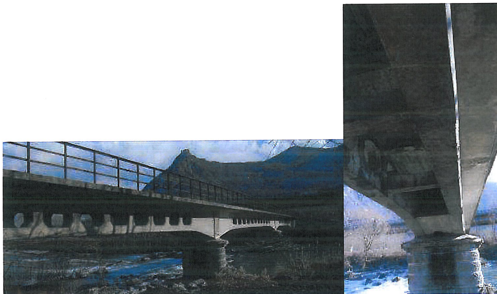
Figura 1 – Foto del ponte
