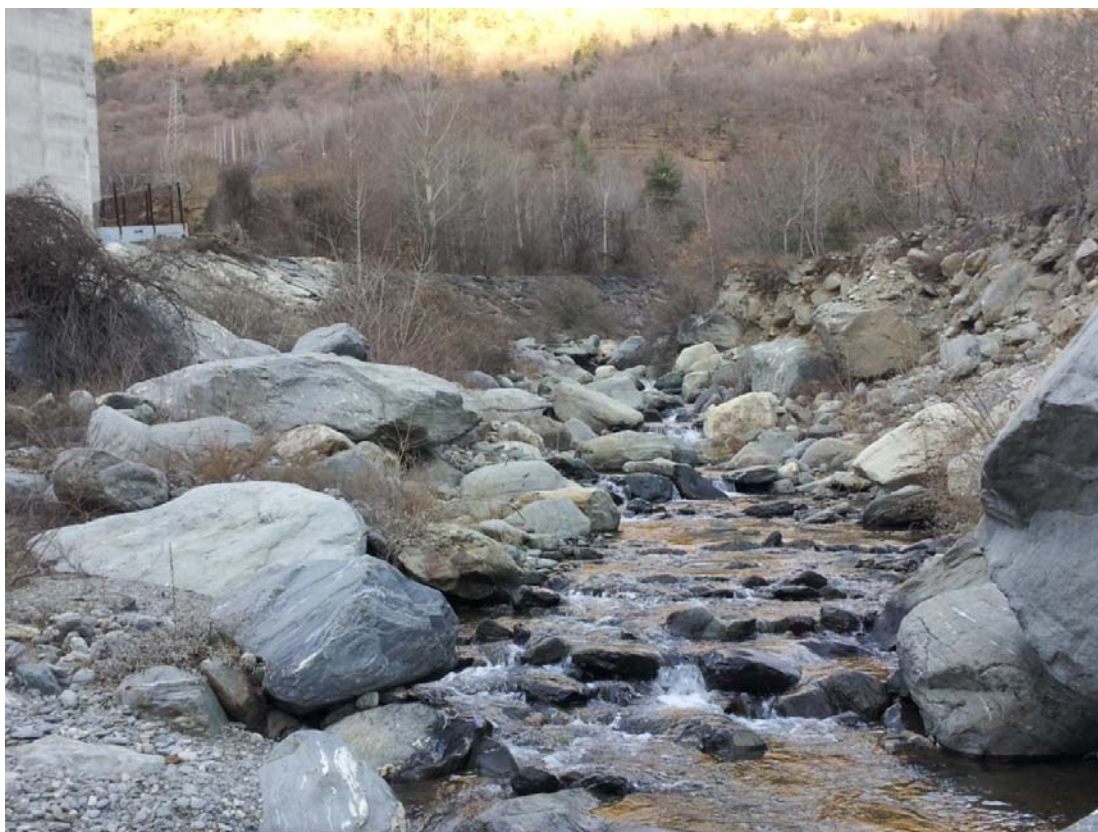
Fig. 10 – Pila P10 in destra idraulica
