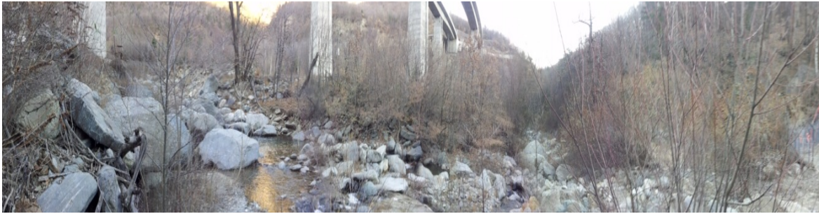
Fig. 7 – Pile esistenti viadotto Clarea
