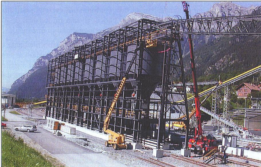
**Figura 2** – Cantiere AlpTransit (Amsteg) – Impianto di caricamento su treno in corso di costruzione (a fine lavori l'impianto sarà completamente chiuso, vedere Figura 1) si noti anche la movimentazione dei materiali mediante nastri trasportatori chiusi.
