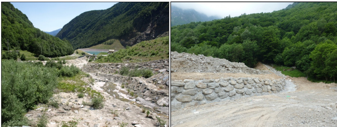
Figura 12–Interventi di sistemazione idraulica del Torrente Clarea: difese di sponda in corrispondenza dell'immissione del RioTiraculo (foto a sinistra, vista dal Tiraculo verso valle); vallo a monte della colonia, in destra Clarea (foto a destra)
