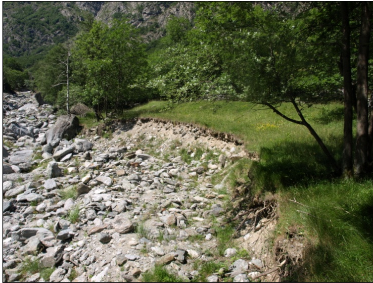
Figura 3– Sponda sinistra del Torrente Clarea a quota 1138 m slm circa. Scarpata di 1,5 m di altezza che separa i depositi torrentizi attuali (a sinistra) da quelli recenti (a destra)
