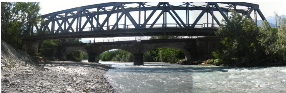
Figura 12 – Ponti ferroviari esistenti sulla Dora Riparia: a campata unica (primo piano) e a tre campate (in secondo piano) (foto da valle verso monte).
