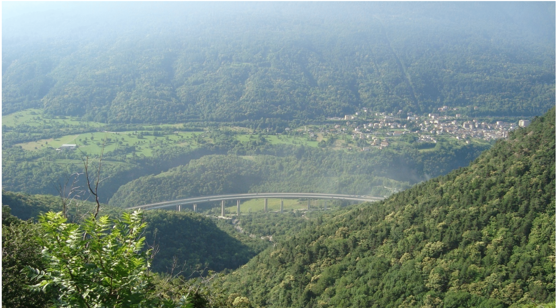
Figura 3 – Fotografia dello stato ante operam dell'ambito di progetto (da SP 225)
