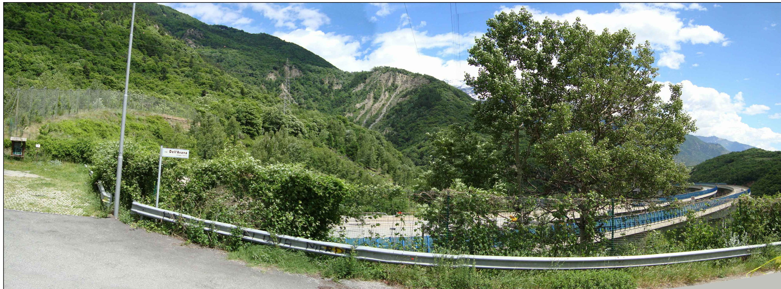
Photo 4: Vue du viaduc Clarea de la voie de l'Avanà / Foto 4 : Vista del viadotto Clarea da Via Dell'Avanà
