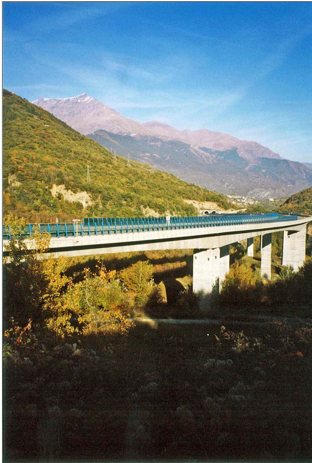
Photo 1: Vue du viaduct Clarea de la voie de l'Avanà / Foto 1: Vista del Viadotto Clarea da Via Dell'Avanà
