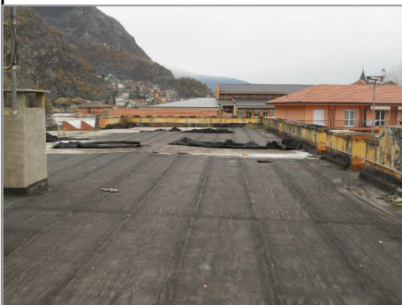
FOTO 4 - Stato di fatto copertura dell'edificio Ex caserma
