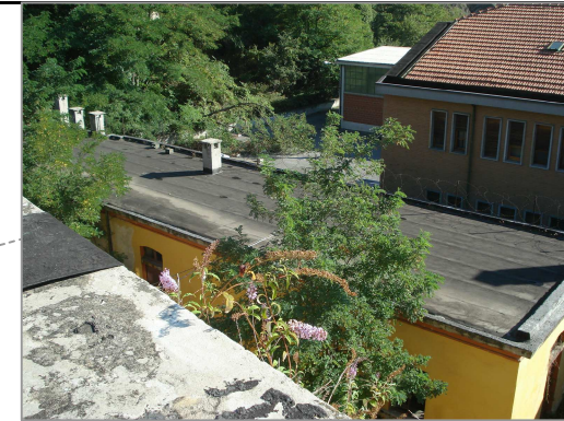
FOTO 5 - Vista copertura Ex foresteria
