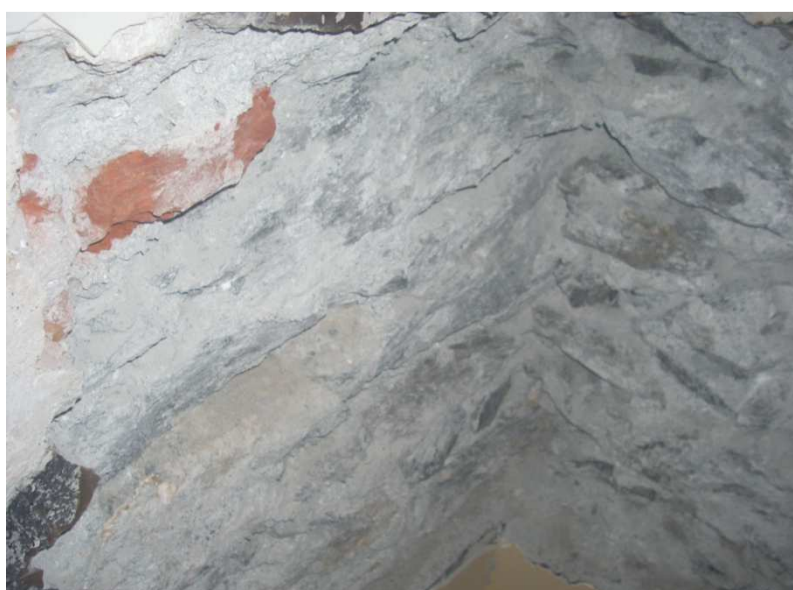
Immorsatura muratura portante
