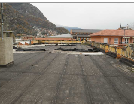
FOTO 4 - Stato di fatto copertura dell'edificio Ex caserma
