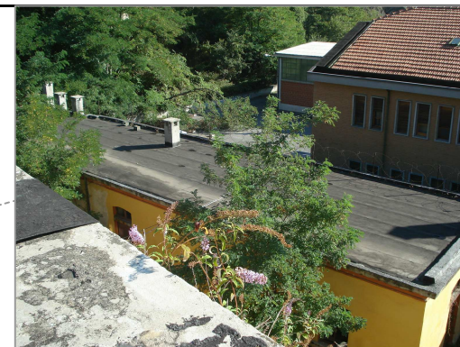
FOTO 5 - Vista copertura Ex foresteria
