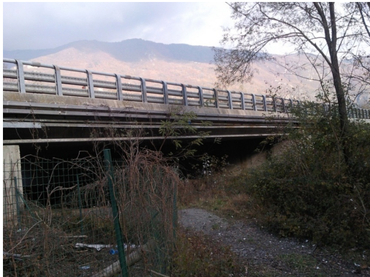
Foto 3: Ponte sullo scaricatore del canale idroelettrico
