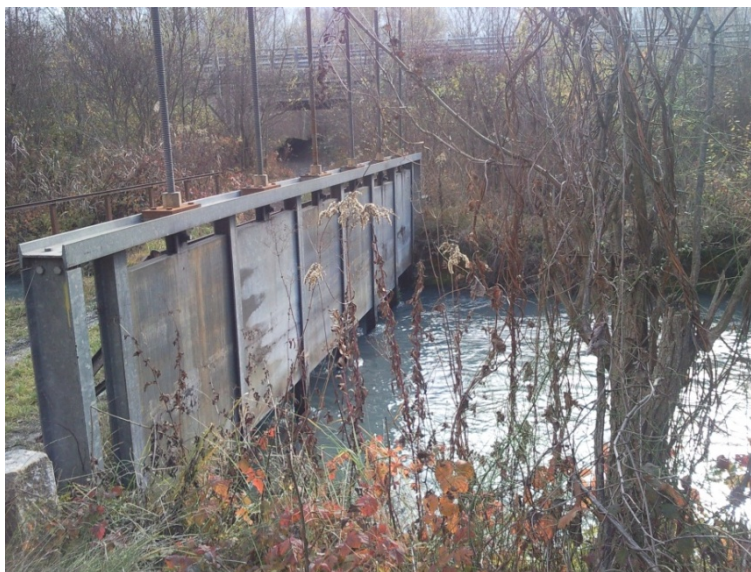
Foto 12: paratoie per la regolazione dello scarico del canale idroelettrico nella Dora Riparia.
