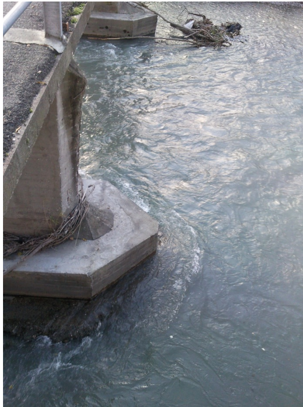
Foto 7: dettaglio delle pile del ponte di via del Lago
