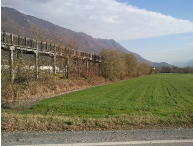
Foto 10: vista dalla via del Lago del tratto di canale idroelettrico poco a monte della centrale
