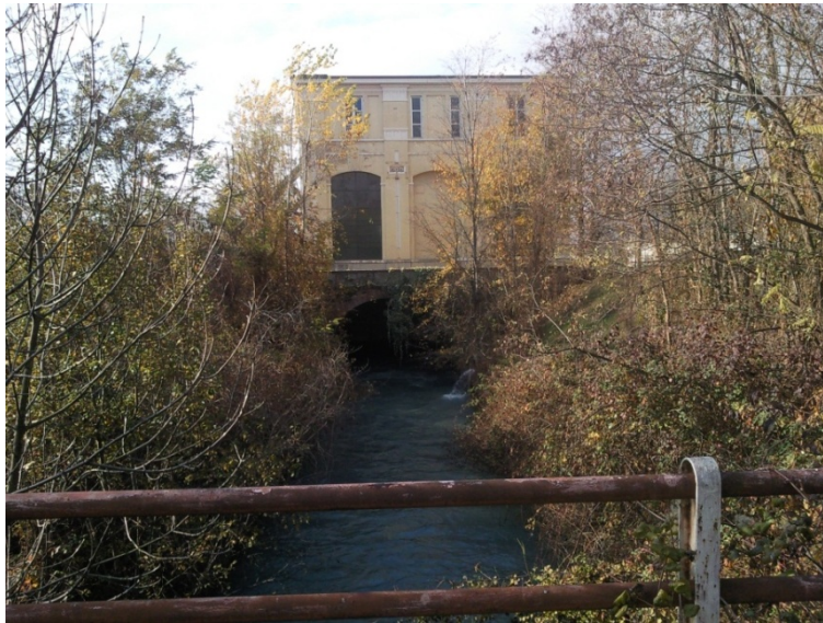
Foto 11: canale idroelettrico immediatamente a valle della centrale N.I.E.
