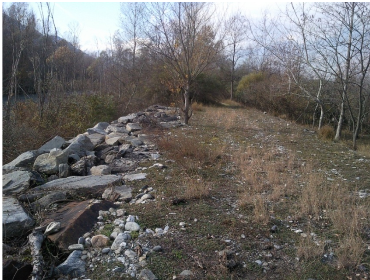
Foto 9: vista verso monte dell'argine in sinistra della Dora Riparia.
