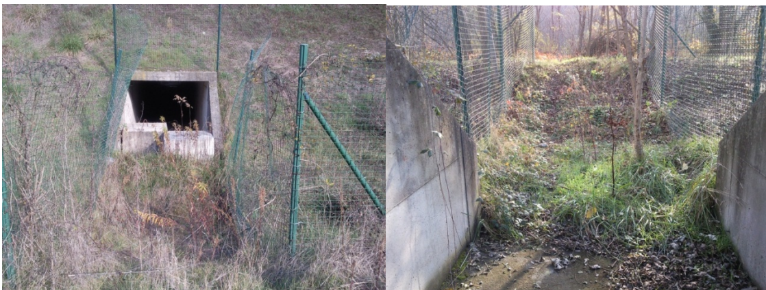
Foto 4 e 5: fornice scatolare nel rilevato autostradale
