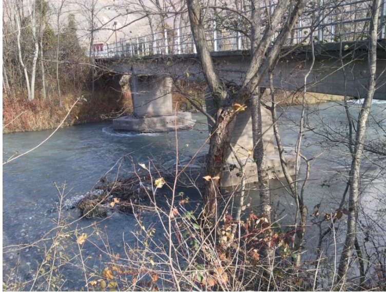
Foto 6: vista da monte ponte di via del Lago
