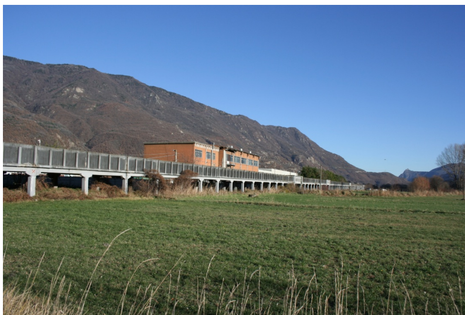
Figura 32: tratto di canale idroelettrico sopraelevato in comune di Bruzolo
