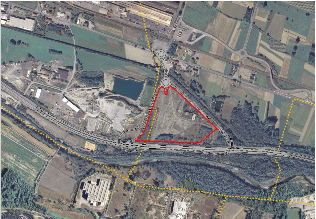
Figura 38: stralcio della foto aerea del sito di San Didero
