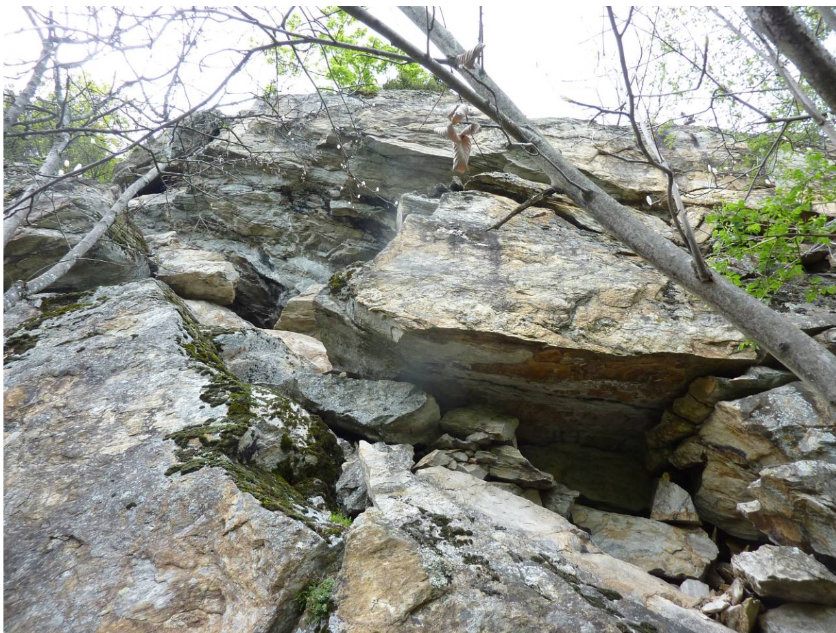
Fig. 5 – Esempio di massi potenzialmente instabili per fenomeni di crollo.
