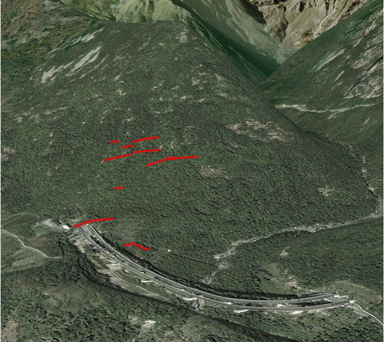
Fig. 11 – immagine del versante in oggetto tratta da Google Earth con rappresentazione schematica (in rosso) delle barriere paramassi osservate durante i sopralluoghi.
