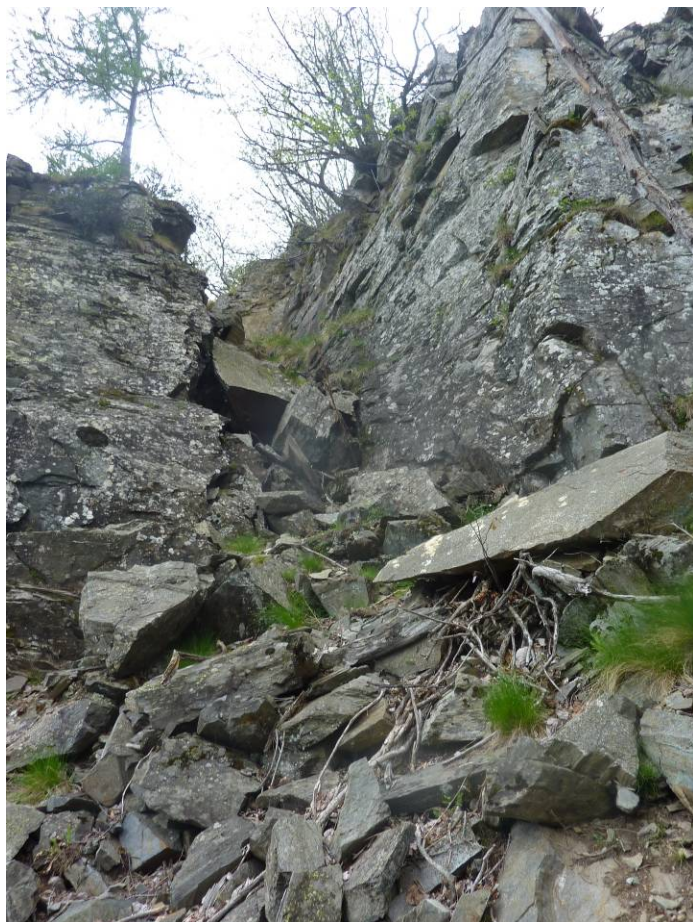
Fig. 10 – Trench parallelo al sistema K1 che isola la porzione rocciosa.
