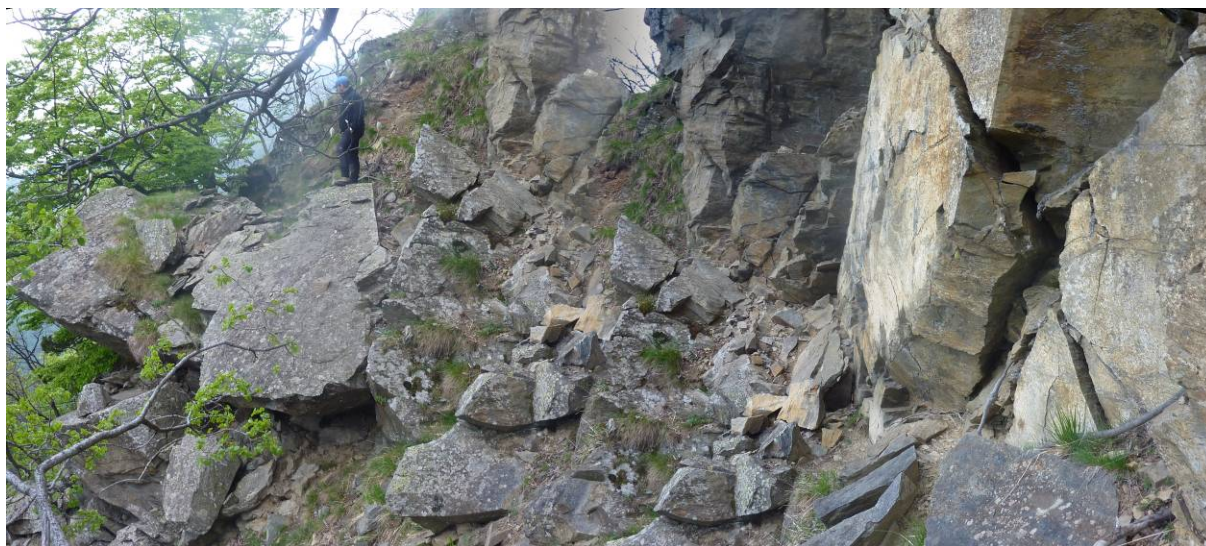
Fig. 11 – Parete frontale della zona rilasciata ( parallelo al sistema K2 ) caratterizzata da crolli recenti.
