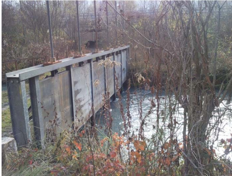
Foto 12: paratoie per la regolazione dello scarico del canale idroelettrico nella Dora Riparia.
