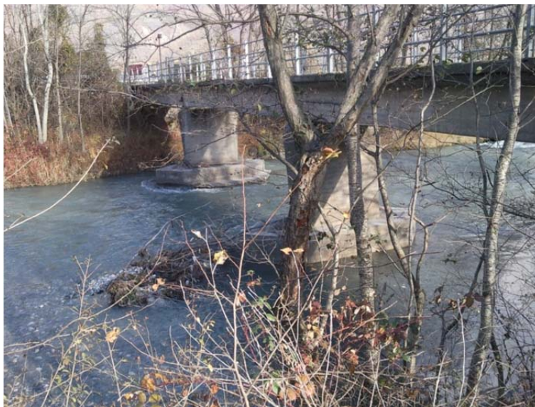
Foto 6: vista da monte ponte di via del Lago
