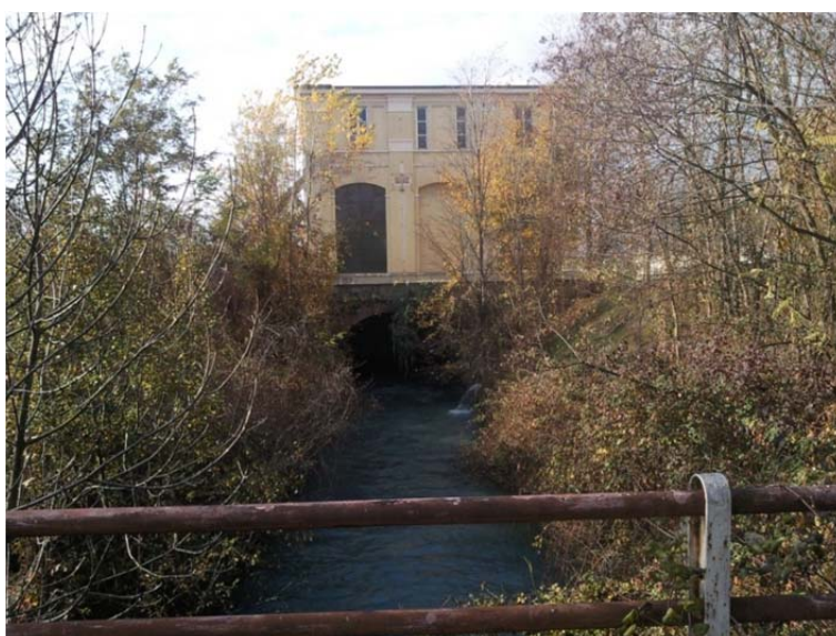
Foto 11: canale idroelettrico immediatamente a valle della centrale N.I.E.
