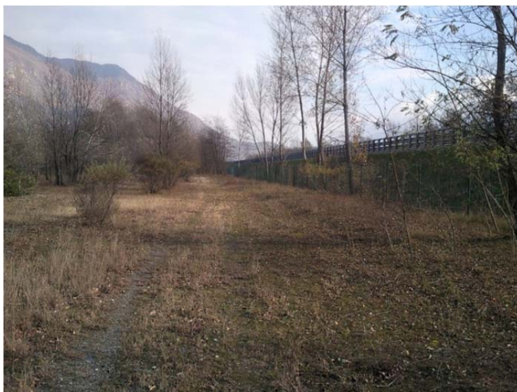
Foto 1: rilevato autostradale in corrispondenza del settore oggetto di intervento
