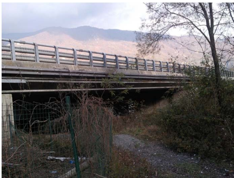
Foto 3: Ponte sullo scaricatore del canale idroelettrico
