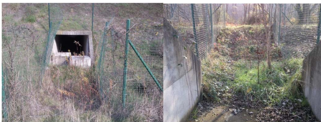
Foto 4 e 5: fornice scatolare nel rilevato autostradale
